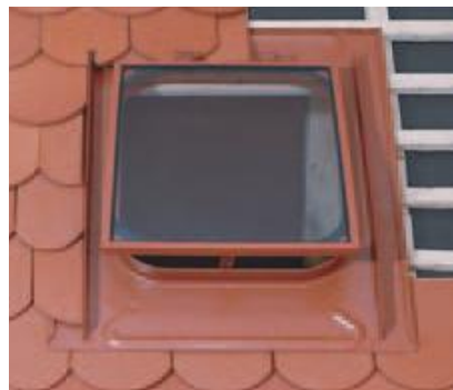
Кровельное окно с примене- нием ленточной черепицы.
