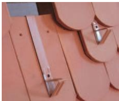
Крепление снегозащитных крюков
