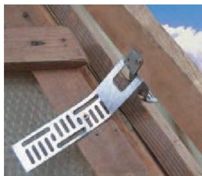
Крепление коньковой рейки универсальным держателем
