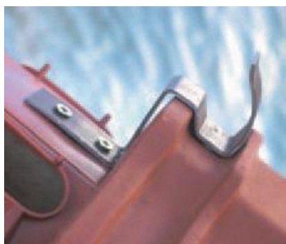
Крепление прессованной коньковой черепицы специальным зажимом
