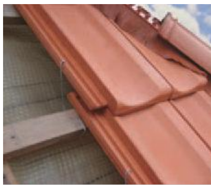
Крепление прессованной черепицы специальным крепежным элементом
