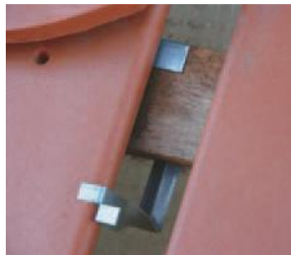
Боковое крепление ленточной черепицы специальным крепежным элементом
