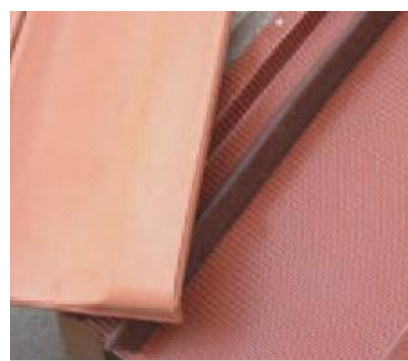
Применение уплотняющей самоклеющейся ленты для ендовы
