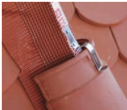
Крепление ленточной коньковой черепицы специальным зажимом
