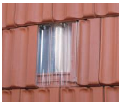
Решение по освещению не утепленного чердачного помещения с использовани- ем прозрачной прессованной черепицы
