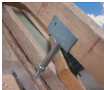
Крепление коньковой рейки держателем с гвоздем
