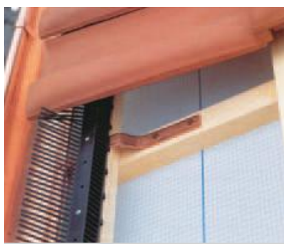
Применение аэроэлемента свеса
