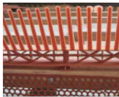
Применение защитной сетки у карнизного свеса
